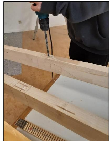
Nach dem Feinschliff der Kanthölzer folgte der Zusammenbau der einzelnen Wand-Elemente mit dem gleichzeitigen Einsetzen der Füllungen. Diese hatten wir vorher weiß grundiert, damit sie demnächst noch farblich gestaltet werden können.
