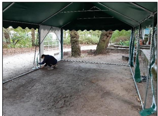
Nachdem alle Rohre zusammengebaut waren und das Grundgerüst stand, musste die Pvc-Plane für die Dachbedeckung aufgezogen sowie die Seitenteile eingehangen und aufgerollt werden. Sämtliche Seitenteile und Giebelseiten sollen nämlich nur, wenn die Witterungsverhältnisse es unbedingt erfordern ausgerollt werden, damit eine optimale Durchlüftung gegeben ist.
