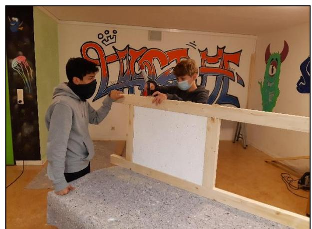
Beim darauffolgenden Zusammenbau der Elemente nahm das ganze dann recht schnell Form an. Was fehlte war nur noch der Einbau der Kunststoffenster in die oberen Öffnungen des Ständerwerks. Diese wurden von maßgenau zugesägten Glasleisten gehalten, die in das Rahmeninnere geschraubt werden mußten. Dabei war genaues Arbeiten gefragt, was die Jungs sehr gut und eigenständig bewerkstelligten.
